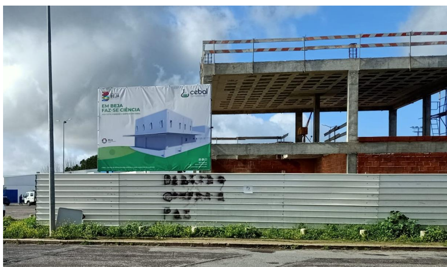
Figura 25. Outdoor de divulgação junto da obra do novo edifício do CEBAL
